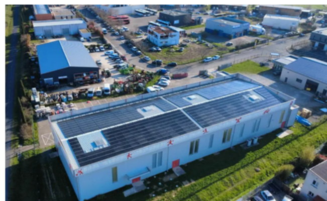
Maison des Sports et de Loisirs - 422 panneaux photovoltaïques (30)
