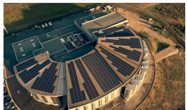
Vue aérienne de la cave Héraclès avec les 864 panneaux photovoltaïques (30)
